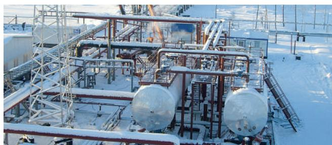
сепаратора трубной обвязкой, площадкой обслуживания, опорами, комплектом запорной арматуры и КИП и А (поставка блока НГСВМ-А).
