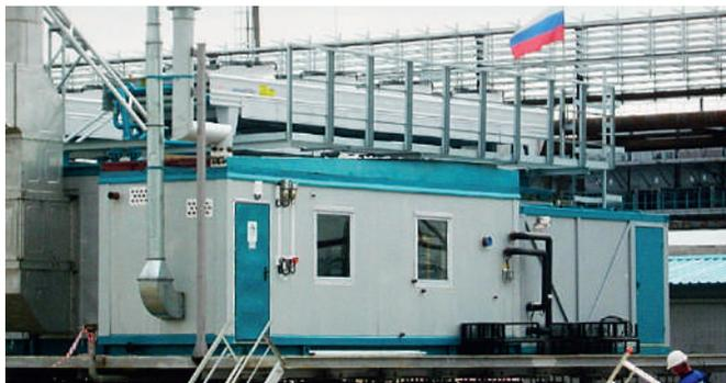
**Блок подготовки топливного газа БПТГ,**
