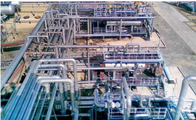
Установка подготовки газа и стабилизации конденсата, Q<sub>газа</sub>=4 000 000 м<sup>3</sup>/сут, Q<sub>конд.</sub> = 700 т/сут. Технология: НТС с дроссель эффектом
